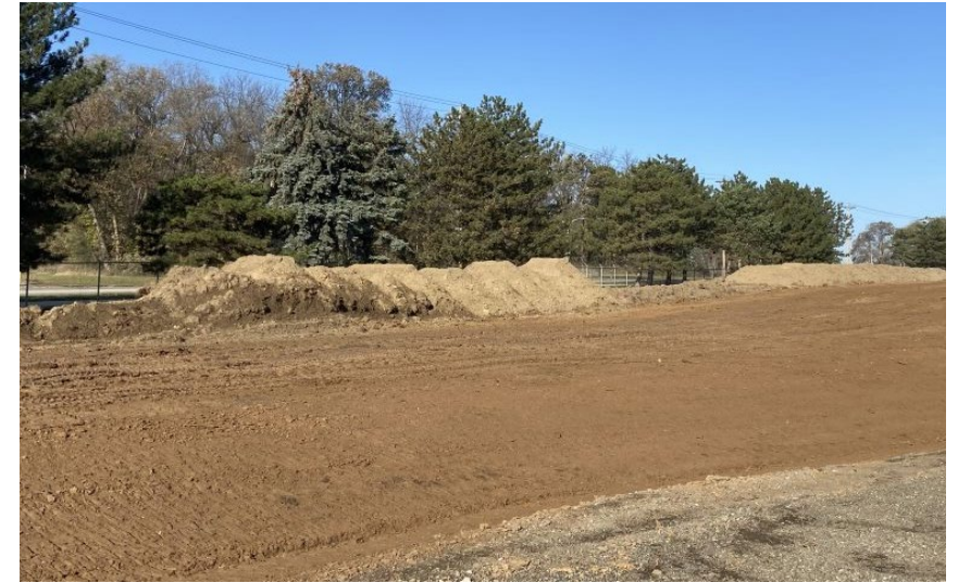
Ash Landfill Progress
