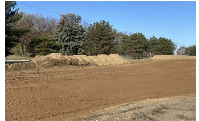
Ash Landfill Progress
